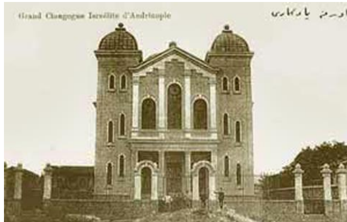
Şekil 1. Edirne Büyük Sinagog Binası (Kaynak: Vakıflar Bölge Müdürlüğü, 2007)
