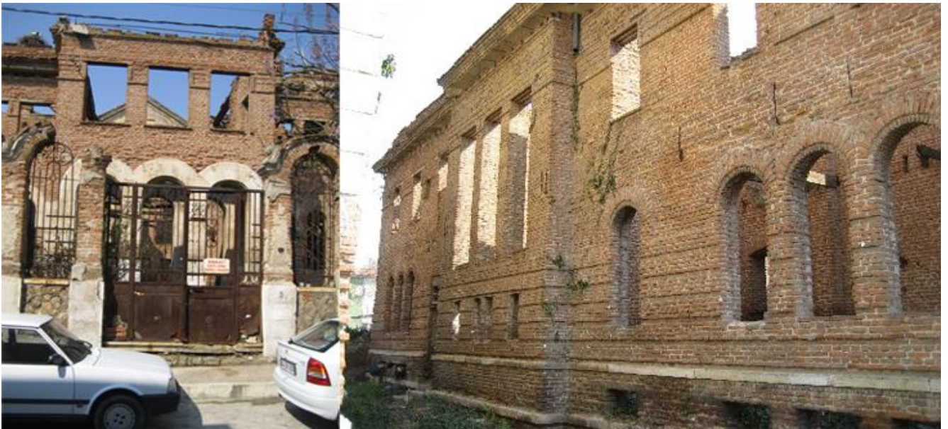
Şekil 7: İdare Binası Giriş ve arka cephesi (Kaynak: Vakıflar Bölge müdürlüğü, 2007)
