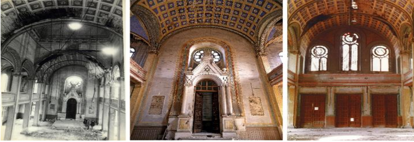
Şekil 2. Sinagog Binası çatısı çökmeden önce iç mekandan görünüm (Kaynak: Vakıflar Bölge müdürlüğü, 2007)
